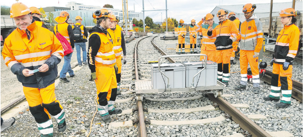
Apprendisti costruttori di binari nell'impianto di formazione della SPB a Sursee.
